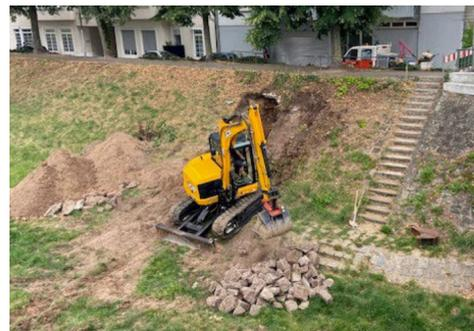
Abb. 19: Pflasterung des Damms, neben der Ankerbrücke zur Straße im Grün
